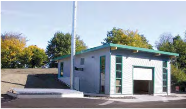
Kesselhaus der Holzhackschnittelheizung und Ladeluke für den Hackschnittelbunker Erich-Fried-Gesamtschule Ronsdorf
