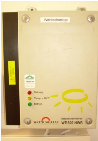
Abb.:Netzwechselrichter Ökostation Bauen und Technik
