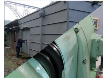
Generator der Wasserkraftanlage an der Müngstener Brücke im Solinger Brückenpark (160 kW). Anfallende Abwärme wird mit Einsatz von Wärmepumpen zur Versorgung der Gastronomie verwendet.
