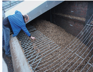
Holzchackschnitzelanlage der Ev. Stiftung Tannenhof in Remscheid. Der Kessel hat eine Leistung von 1 MW für die Grundversorgung mit Wärme.
