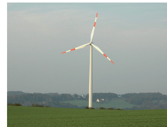
Windkraftanlage in Velbert/Kreis Mettmann. Die Anlage an der Stadtgrenze zu Essen besitzt eine Nabenhöhe von 100 m; ihre Leistung beträgt 1,5 MW.
