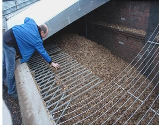
Holzchipschnitzelanlage der Ev. Stiftung Tannenhof in Remscheid. Der Kessel hat eine Leistung von 1 MW für die Grundversorgung mit Wärme.
